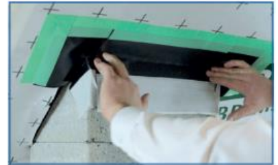
Unutarnji kutovi s bazom od žbuke
