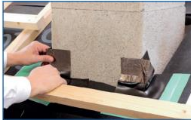
Unutarnji kutovi bez gipsane podloge
