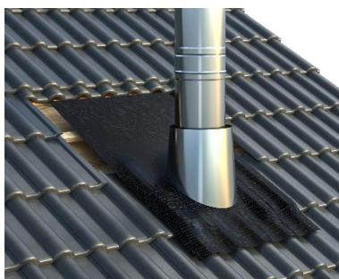
4. Prilikom lijepljenja lijepo oblikujte elastomer, prateći oblik pokrova, ispod, lijevo i desno od dimovodnog sistema.
