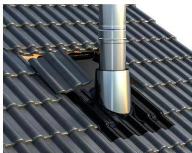
10. Vratite uklonjeni crijepljivo/pokrov. Možda će biti potrebno prilagoditi (urezati) dio crijepla.
