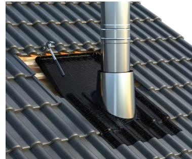
9. Sada postavite elastomer na prethodno pripremljenu letvu (korak 6) i pričvrstite elastomer za nju s vijcima ili čavlima na tri mesta (lijevo, desno i u sredini)
