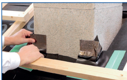
Unutarnji kutovi bez nosača žbuke
