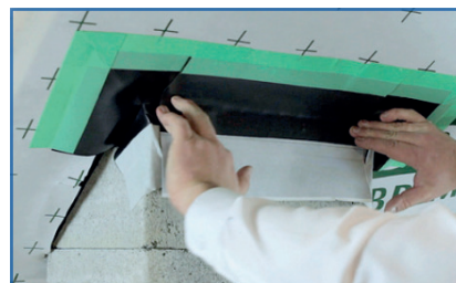
Unutarnji kutovi sa nosačem žbuke
