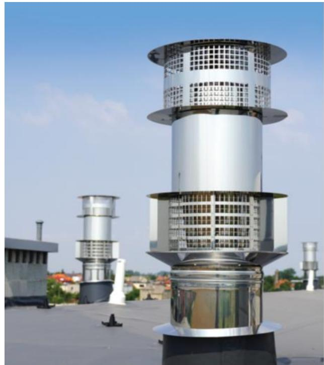
> odvod dimnih plinova i istodobna isporuka svježeg zraka za sagorijevanje za pojedinačne izvore topline sa zatvorenom komorom sagorijevanja u zgradama može se riješiti sa kolektivnim ventilacijskim i dimovodnim sistemima Jeremias CLV ili LAS. Korištenje kolektivnih sistema sprječava niz problema koji utječu na pravilno funkcioniranje kotla, na primjer:
